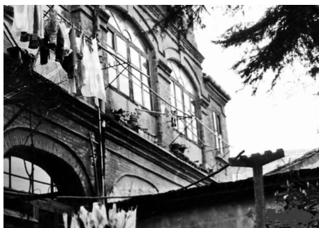
原北京西路 690-696 号俄式洋房外貌
